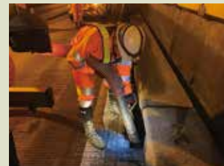
集水ます清掃作業
