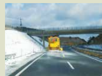
凍結防止剤散布作業
