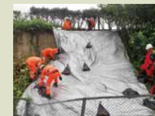
緊急応急復旧
