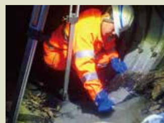
円型水路補修
