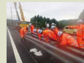
災害復旧工事
