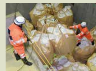
凍結防止剤荷下ろし
