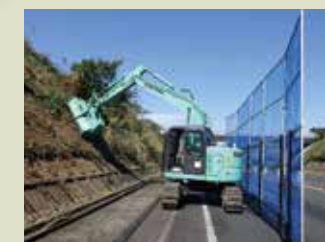
機械伐採(切土部)
