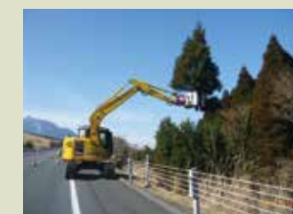
機械伐採(盛土部)
