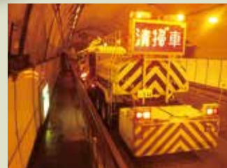
トンネル清掃作業
