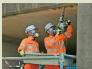
C-BOX補修工事
