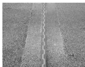
施工完了（横歯型ジョイント）
