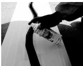
防錆処理・プライマー塗布
