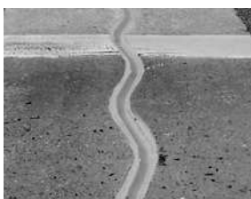
施工完了（縦歯型ジョイント）
