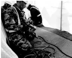
既設止水材撤去
