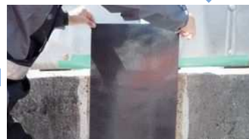
④ シート貼付け
