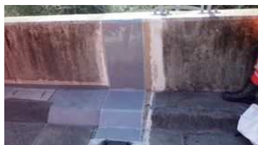
⑥ 施工完了
