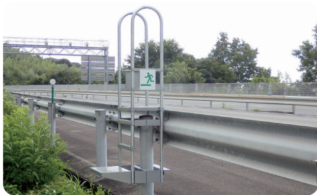
ガードレール
