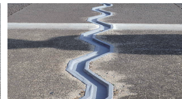
[九州道 大野高架橋] (施工: 令和3年1月)
