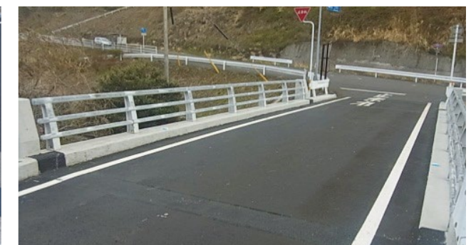
[大分県 浦久保橋] (施工:平成25年12月)
