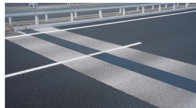
[長崎道 撰分橋] (施工:平成24年3月)
